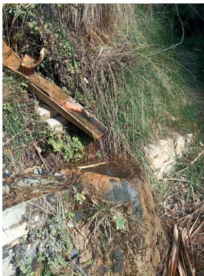
Foto 8. Detalle de la surgencia de la mina del Turc en la que se observa el reducido caudal que habitualmente presenta.
