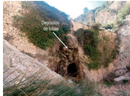
Foto 2. Vista de la presa del Pantanet en la que se puede observar los depósitos de tobas desarrollados en su zona central, así como su anclaje en las calcarenitas del Mioceno medio.
