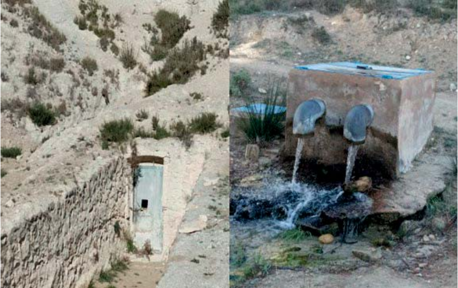
Foto 4: Entrada de la mina de Puça emplazada sobre las margas del Tap 2 (izquierda). Arqueta donde se distribuye el agua; los caños de agua que se ven van al cauce de la rambla de Puça con fines medioambientales (derecha).
