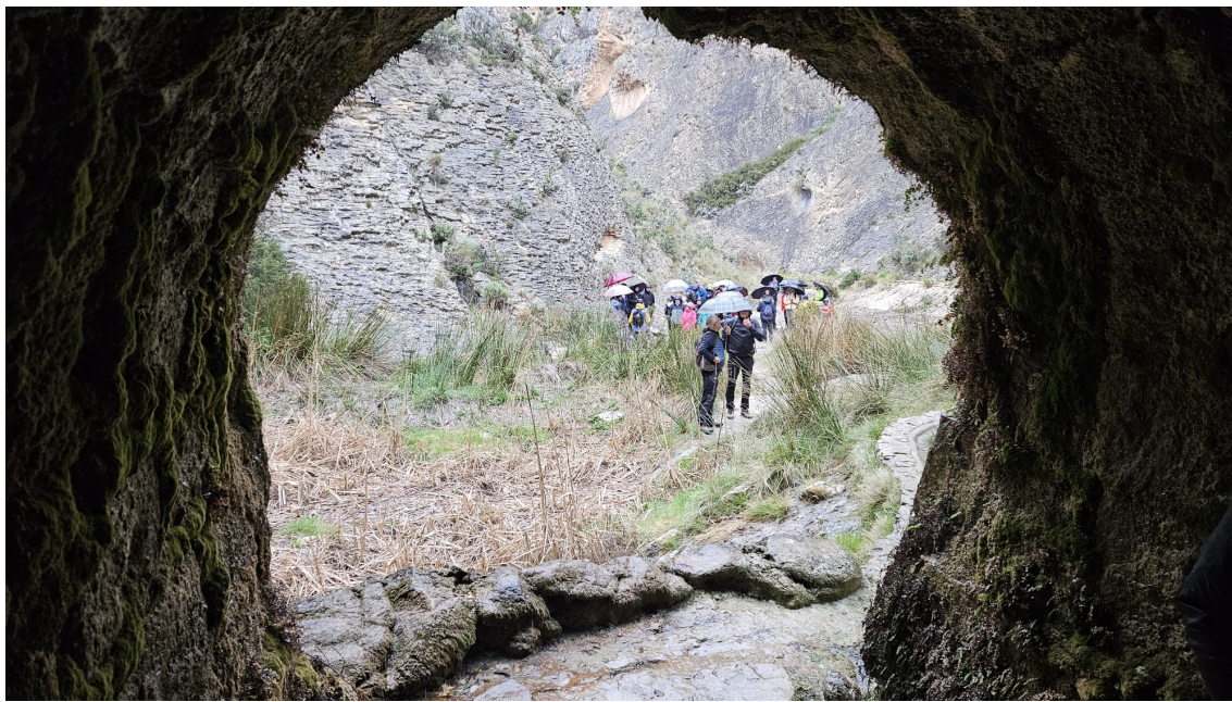
Vista desde el interior de aliviadero de el Pantanet de Petrer.
