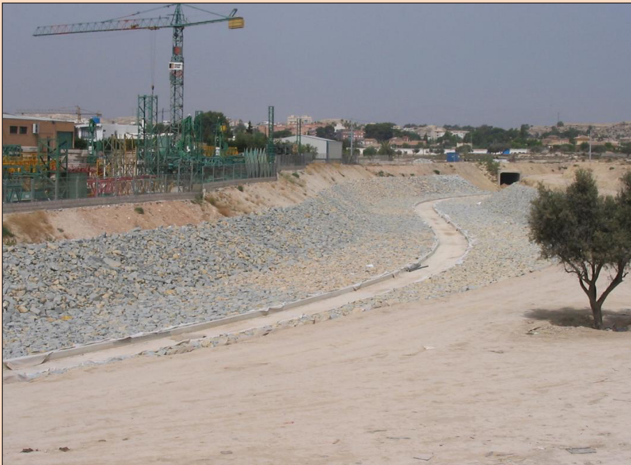
FIGURA 13: Encauzamiento de la rambla
